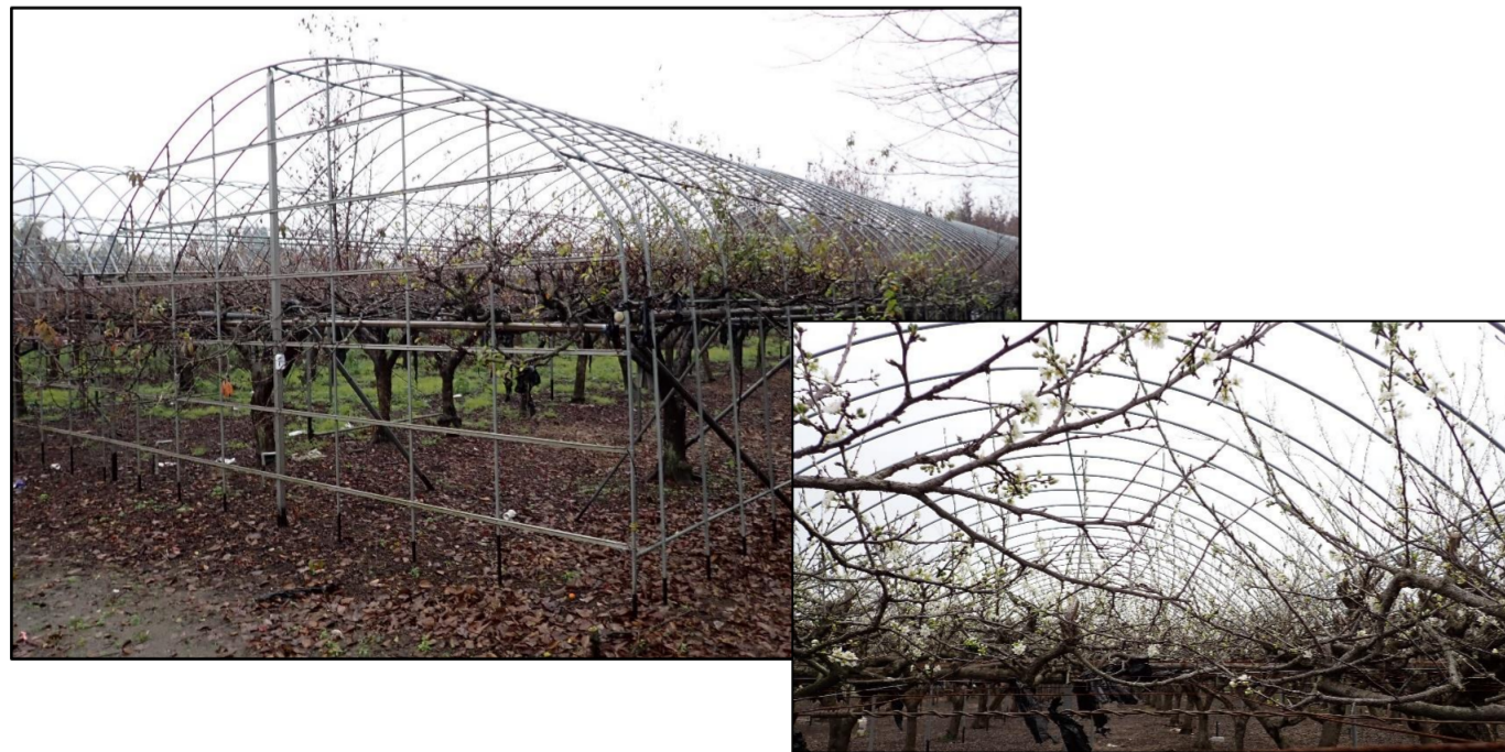
6連棟の鉄骨ハウス(すもも栽培) 植栽後15年経過
